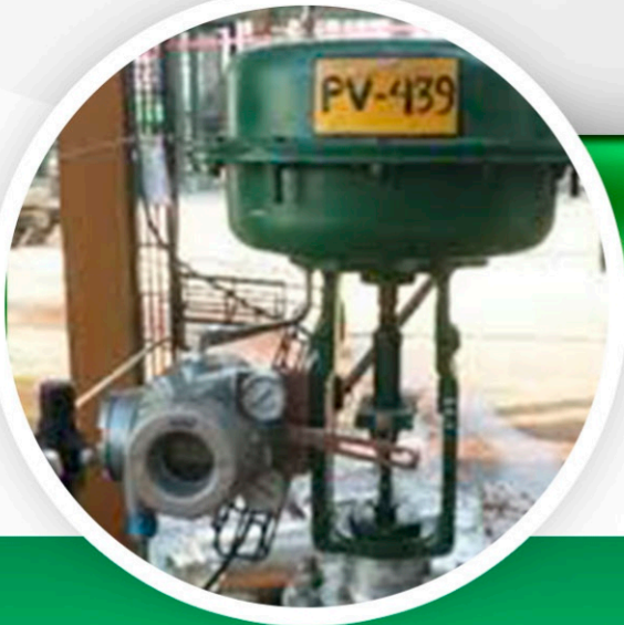
Posicionador Inteligente Universal Serie 700 operando una válvula de globo marca Masoneilan
