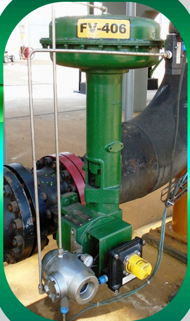
Posicionador Inteligente Universal Serie 700 operando una válvula de rotativa marca Fisher
