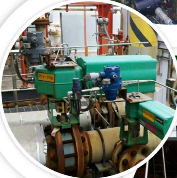
Posicionador Inteligente Universal Serie 300 operando una válvula de rotativa marca Neles-Jamesbury
