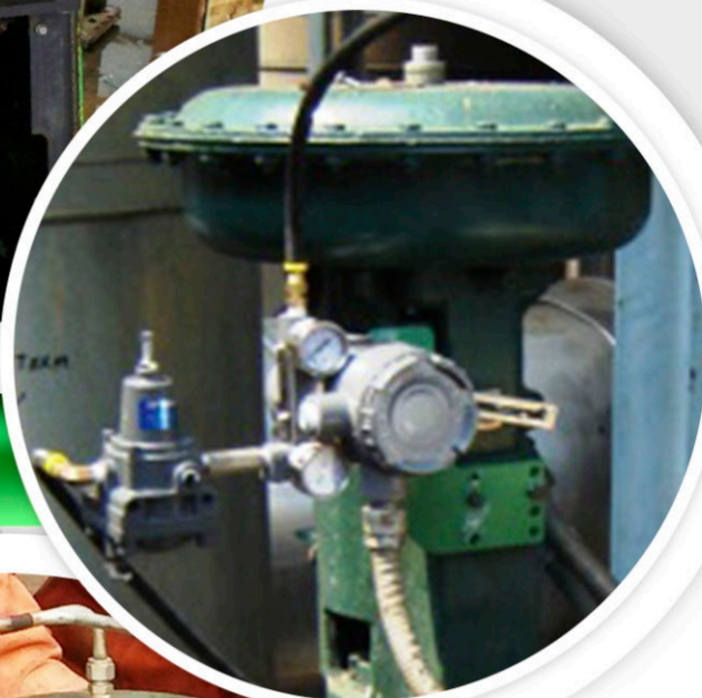
Posicionador Inteligente Universal Serie 300 operando una válvula de globo marca Copes-Vulcan
