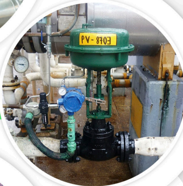
Posicionador Inteligente Universal Serie 300 operando una válvula de globo marca Masoneilan
