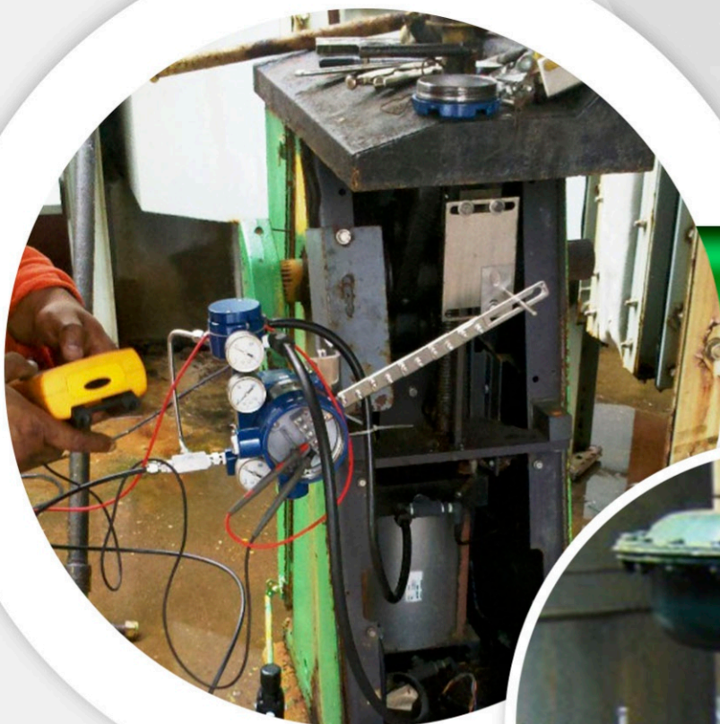
Posicionador Inteligente Universal Serie 300 operando una válvula de globo marca Copes-Vulcan
