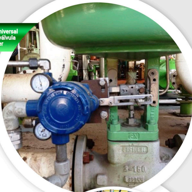
Posicionador Inteligente Universal Serie 300 operando una válvula de globo marca Valtek Flowserve
