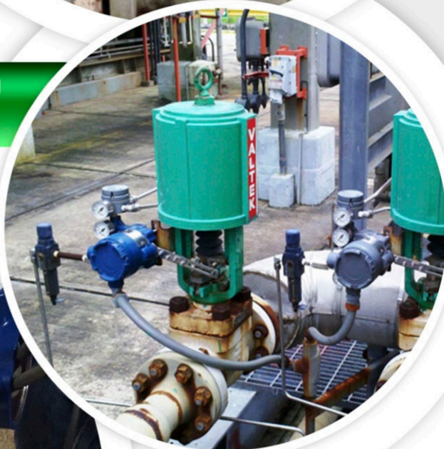
Posicionador Inteligente Universal Serie 300 operando una válvula de globo marca Valtek Flowserve
