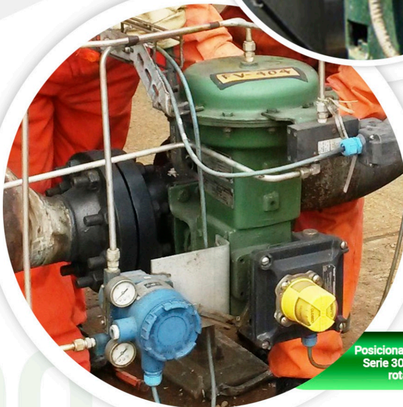
Posicionador Inteligente Universal Serie 300 operando una válvula de globo marca Copes-Vulcan
